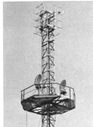
Bild 3. Antennenmast mit vier Achterfeldern und den Endstellen der Richtfunkstrecken
