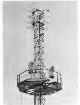
Bild 3. Antennenmast mit vier Achterfeldern und den Endstellen der Richtfunkstrecken
